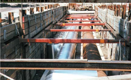
Verbau mit Gurtung / Kanalstreben
