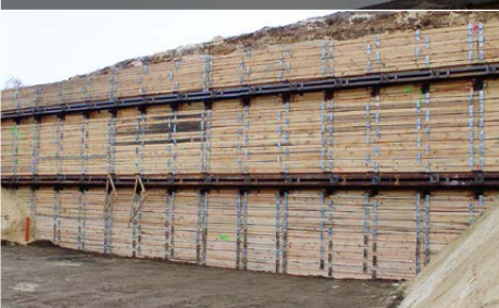
Verbau mit Gurtung / Kanalstreben
