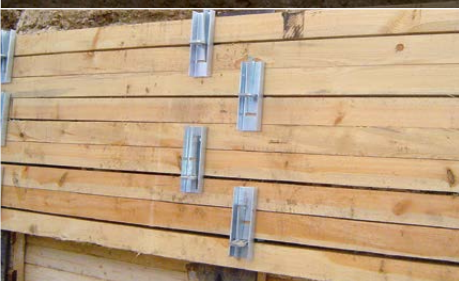
Rückverankerter Verbau
